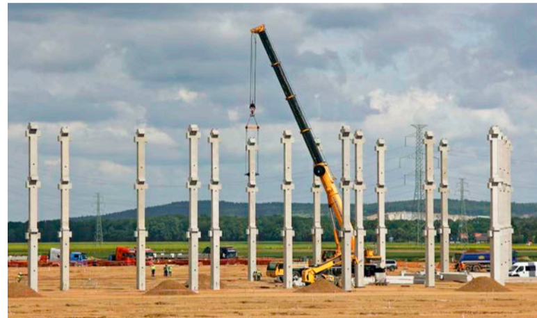
Budowa WSSE Podstrefy Dobromierz
