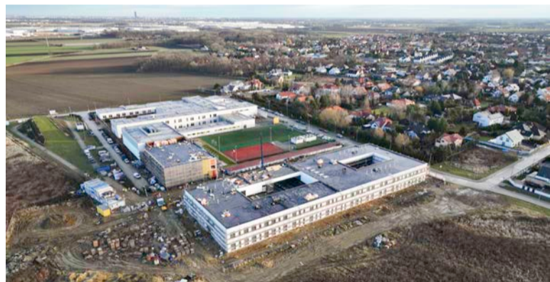
Rozbudowywana szkoła w Tyńcu Małym
